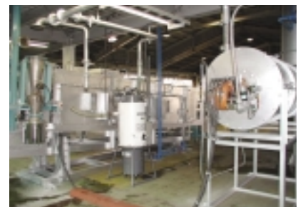
汚泥のリサイクル化試験プラント (山陽工場)
