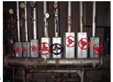
蒸気配管の保温 (FDKエナジー)
