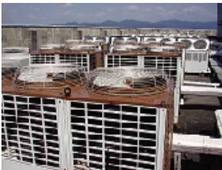
空調室外機への水滴散布配管設置 (湖西工場)
