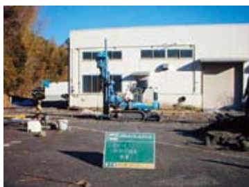
大須賀工場での土壌ボーリング調査
