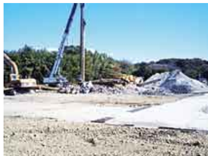
旧大須賀工場でのコンクリート解体風景
