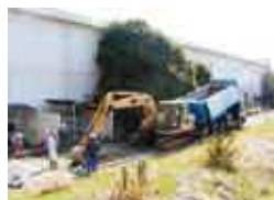
掘削除去工事
