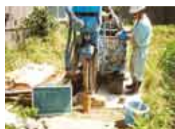
ボーリング調査
