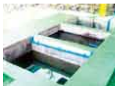
フライアッシュ汚泥の廃水処理装置
