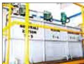
オーバーホールした排水処理施設
