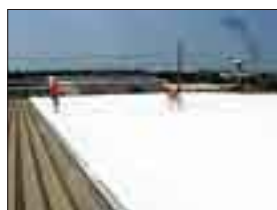
工場屋根への断熱塗料塗布
