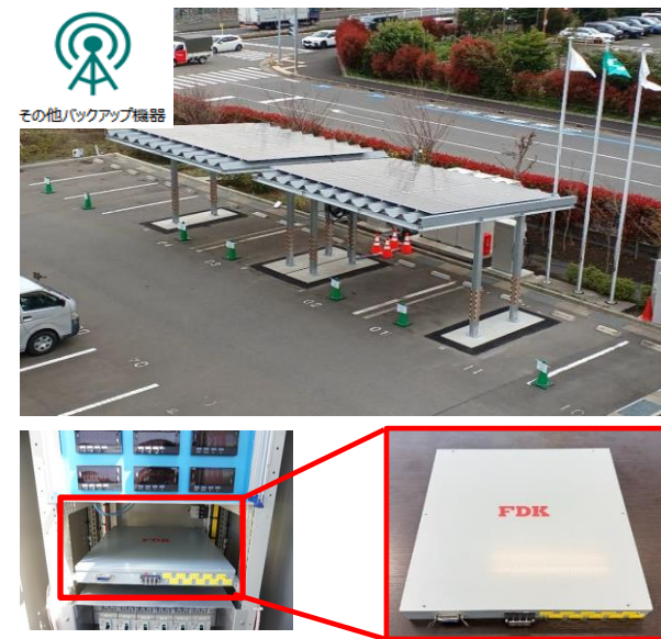
[エクシオグループ(株)様グリッドフリーソーラーカーポート] ※停電時のシステム制御用のバックアップ電源
