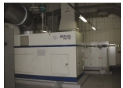
コージェネレーションシステムの導入 (湖西工場)
