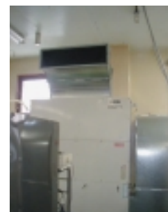
外気取り込みによるエアコンの省エネ (いわき工場)
