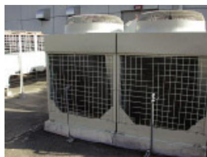
空調機室外機への水滴散布による冷却(湖西工場)
