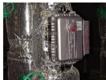
冷却水ポンプのインバータ化(湖西工場)
