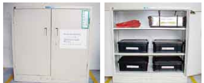
PCBの保管状況(いわき工場)
