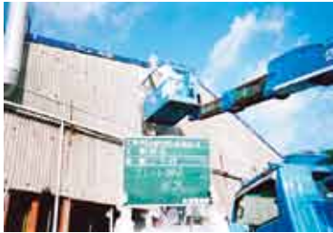
旧大須賀工場2号館解体工事 (スレート手ばらし撤去状況)
