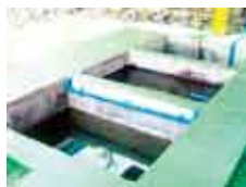
フライアッシュ汚泥の廃水処理装置
