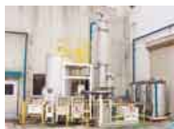
浄化装置設置
