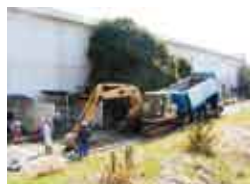
掘削除去工事
