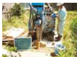
ボーリング調査
