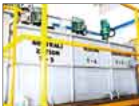
オーバーホールした排水処理施設
