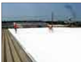
工場屋根への断熱塗料塗布
