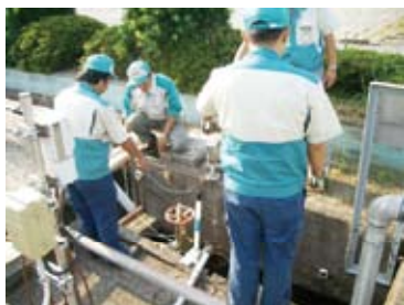
排水処理装置の故障を想定した対応訓練 (湖西工場)
