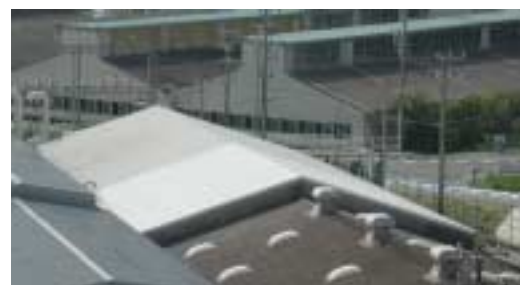
遮熱塗料塗布（湖西工場 5号館）
