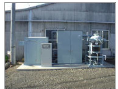
土壌浄化装置（山陽工場）
