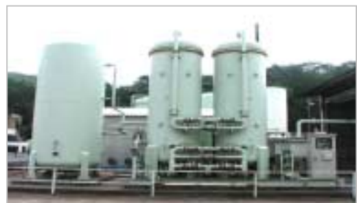
窒素ガス発生装置の省電力化（山陽工場）
