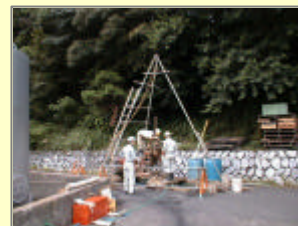
ボーリング調査
